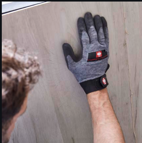
Fugenlose Plattenverklebung auf Stoß. Dank Verbundabdichtung mit Entkopplungsfunktion.
