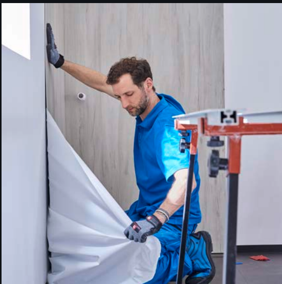
Duschrückwände und hohe Keramikplatten von oben nach unten verkleben.
