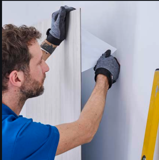
Rückwand positionieren. Schutzfolie auf der Rückseite lösen.
