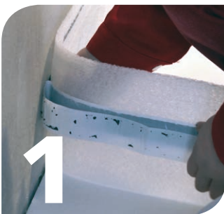
1 VERLEGUNG DES RANDDÄMMSTREIFENS
