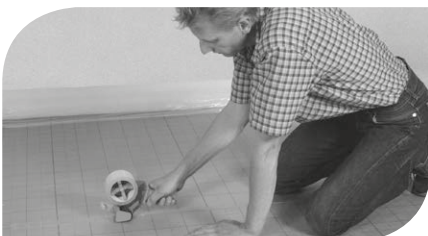
Abb. 4: Dämmrollen sind mit einem 3 cm Selbstklebestreifen versehen und überlappen am Stoß.
