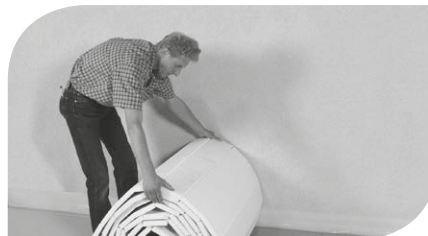
Abb. 2: Tackersystemelemente auslegen und ausrollen.
