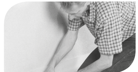
Abb. 3: Randdämmstreifen (beim Einsatz von Fließestrich) abkleben.
