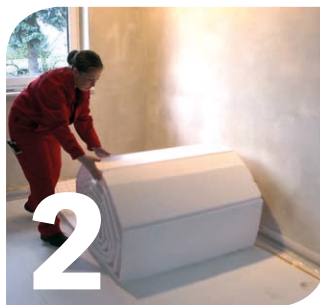
2 DÄMMPLATTEN AUSROLLEN
