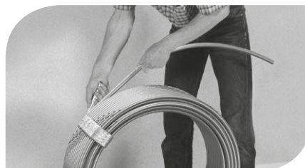
Abb. 5: Tackersystem-Heizrohr mit Hilfe des ...
