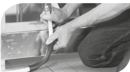
Abb. 7: Heizrohr am Verteiler anbringen, fertig!
